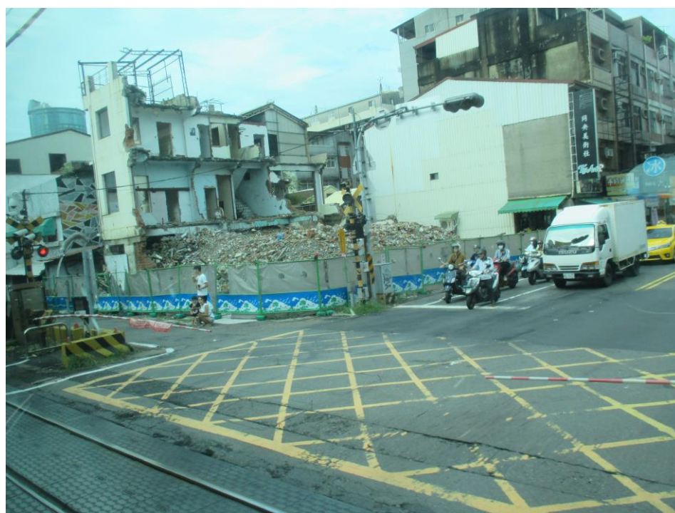
2019.7.11：鐵路旁(靠東邊)進行地下化工程拆除房屋
