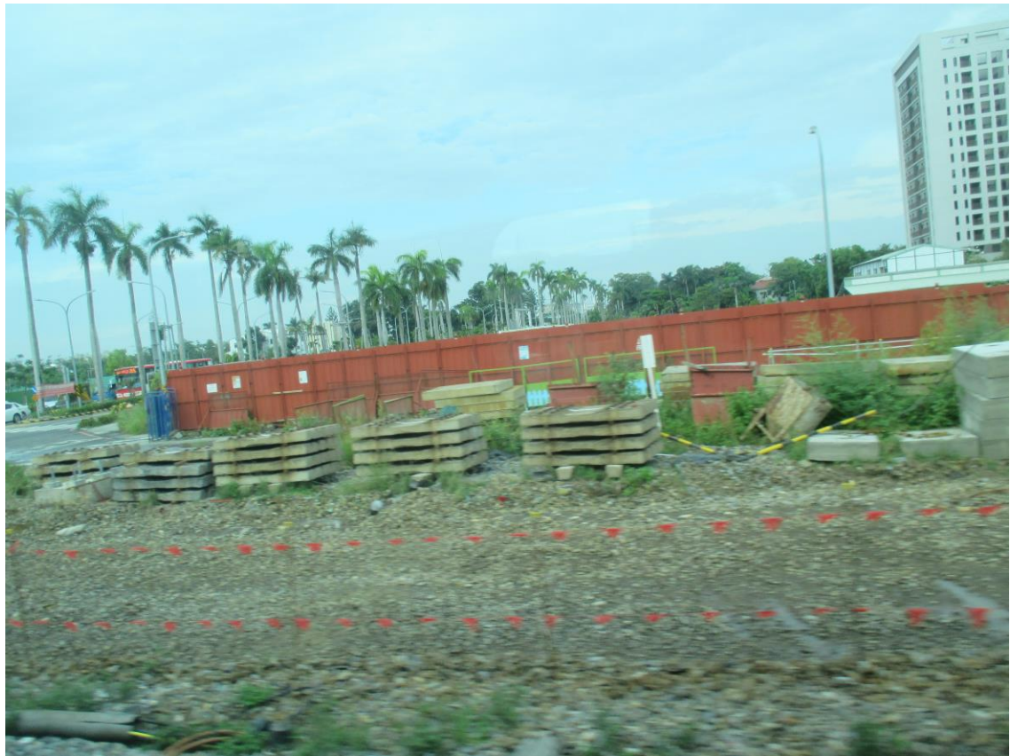
2019.6.27：鐵路旁(靠東邊)進行地下化工程 (椰子樹林是通往糖試所生產路)
