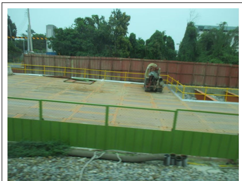
2019.5.8：鐵路旁邊正進行地下化的作業工程
