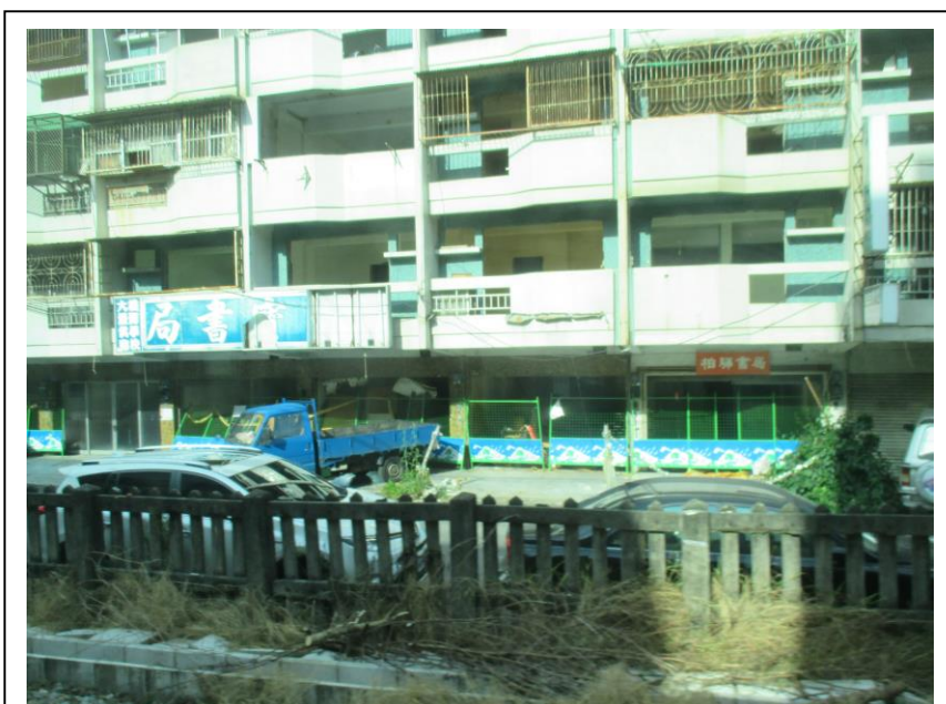
鐵路旁待拆除之房屋 (2019.7.25 拍攝)
