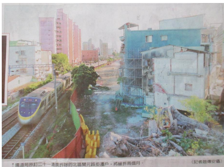
2020.7.22：報載台南市鐵路地下化拆除沿路建築物照片
