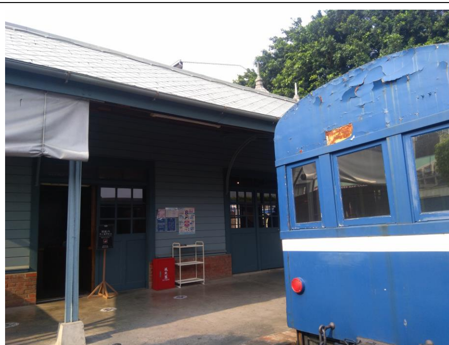
2021.4.16：旗山火車站現場（台糖的鐵路火車站）
