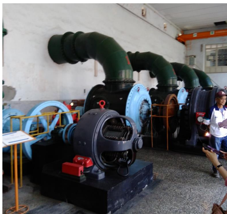
2021.4.16：發電廠房(共有三層)之一樓水輪發電機室
