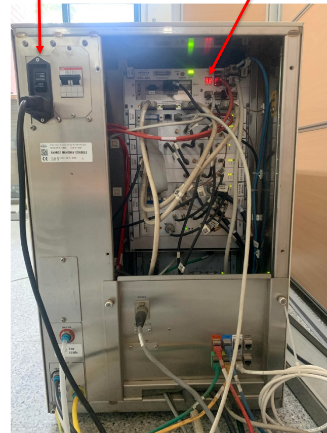
400 NMR Console 面板
