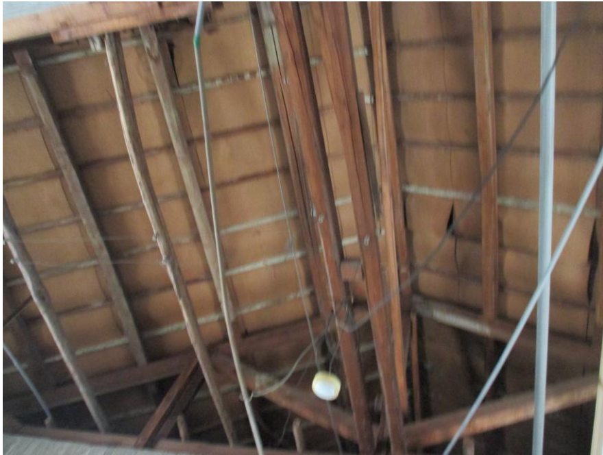
2017.12.1：天花板上之建構屋頂木材及各種管線
